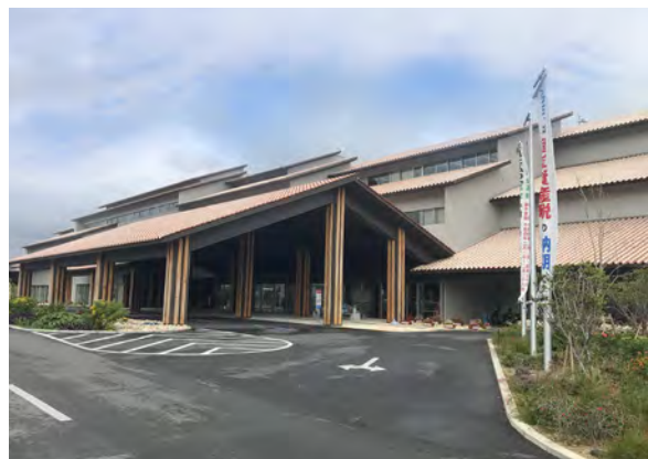
▲2021年11月に完成した石垣市の新庁舎
